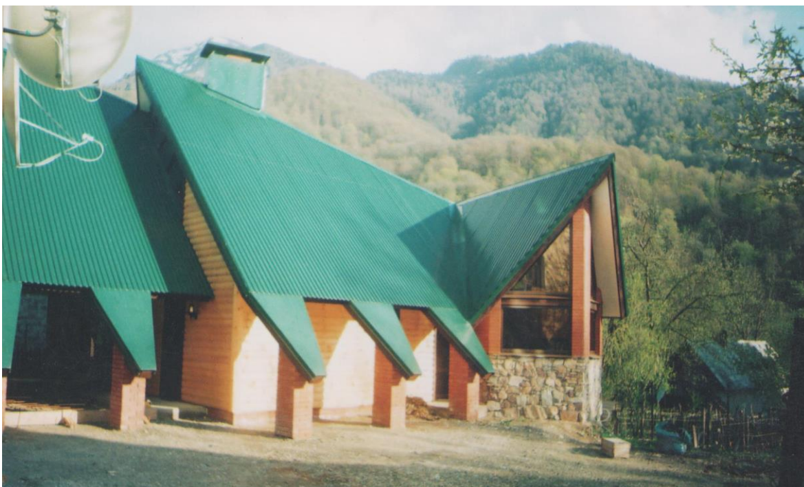
Здание сауны и бильярдной в гостиничном комплексе «Беринг».
